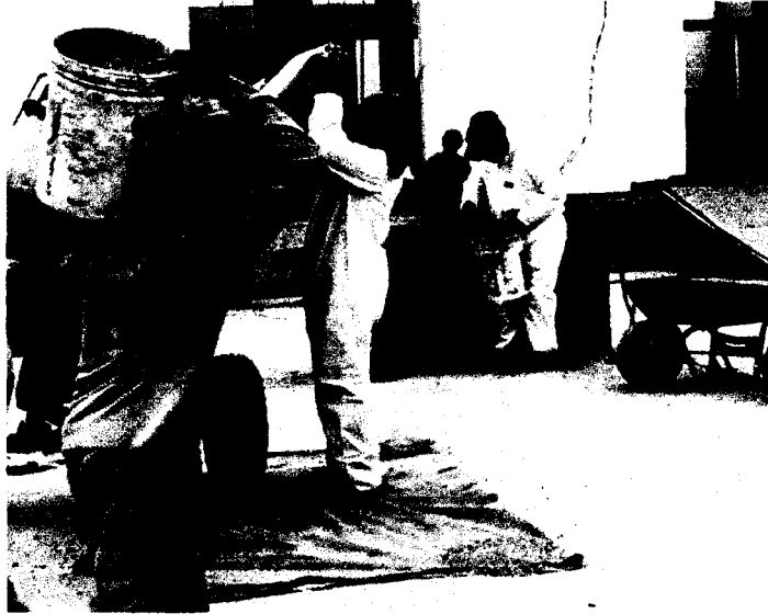
Foto26: Ropa Tyveck para trabajos con cemento
