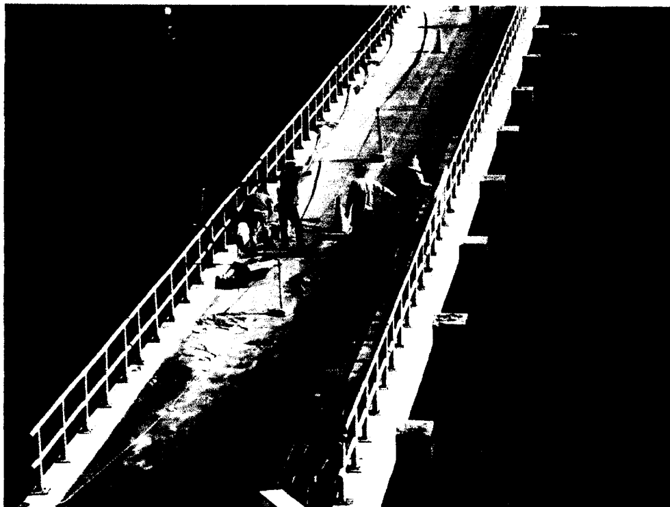
Foto N° 09: Tratamiento a barandas de ingreso al muelle.
